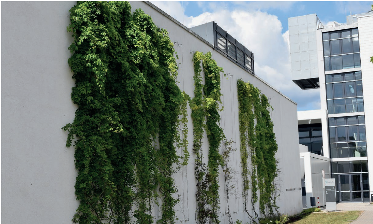
Abb. 63: Bodengebundene Fassadenbegrünung Quelle: Bundesverband GebäudeGrün e.V.
