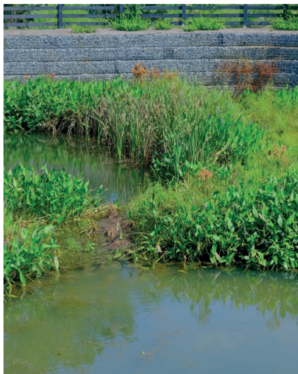
Abb. 21: Retentionsbecken mit Begrünung Quelle: dbvirago / stock.adobe.com
