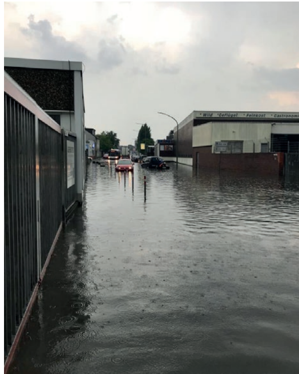
Abb. 51: Wasser auf der Straße „Auf der Höhe“ dringt unter dem Tor in den Hof ein; Quelle: Fa. Gerber
